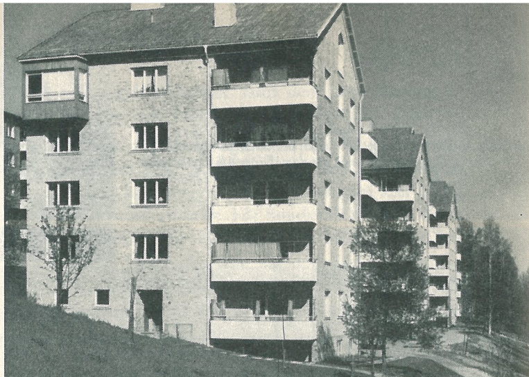
Tre av AB Hyresbostäders hus i kv. Eldaren, ritade av arkitekt SAR Nils Grafström och uppförda 1948—50 i gult sandat Röbo-tegel av Byggnads AB Hallström & Nisses.
