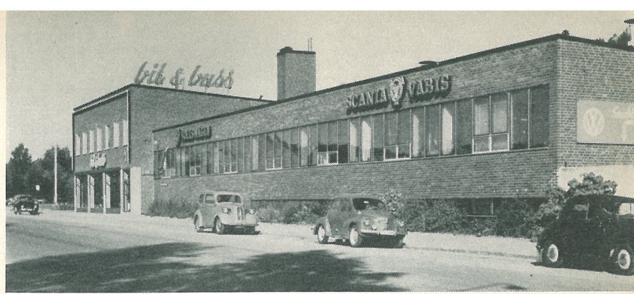
Bil & Buss i Sundsvall AB, 1951—52. Zimdahls Arkitektkontor AB (arkitekt SAR Anders Berg). Byggnadsfirman Anders Diös AB, Sundsvall. Rött valsat Lina-tegel.
