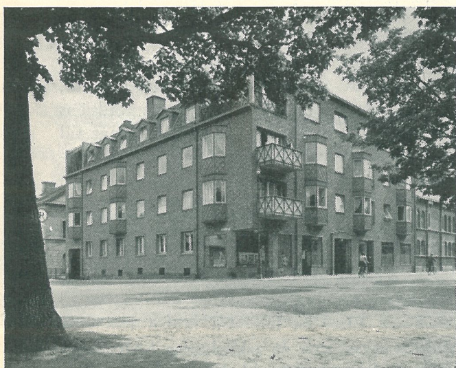
Bostadsrättsföreningen Tillbudet, 1944—45. Arkitekter SAR G. Wejke och K. Ödeen. Byggnads AB Hallström & Nisses. Rött sandat fasadtegel från Röbo.
