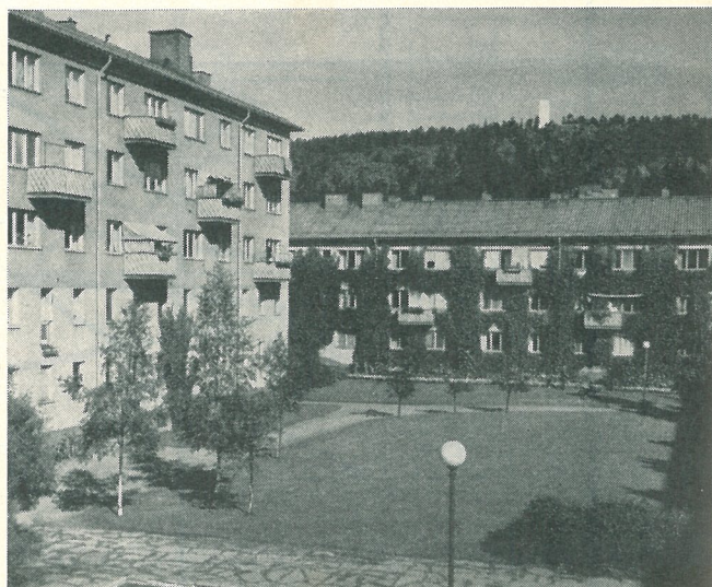
HSB-bus, "Sandgropen", 1944—45. Projekterat av HSB (arkitekt SAR Disa Wahlund). Byggt av Byggnads AB Hallström & Nisses, Sundsvall. Gult chamotterat fasadtegel från Bergsbrunna.
