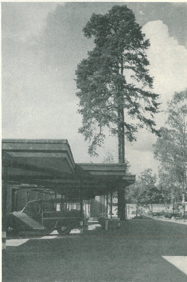
Vinjettbilden visar motellet Gyllene Ratten, sett från Södertäljevägen — "Riksettan". Anläggningen är uppförd av spånat fasadtegel från Sundsviks Bruk AB. T. h. Varje gäst har eget parkeringsutrymme för sin bil i omedelbar anslutning till den separata ingången till sovrummet. Bilen parkeras under ett utskjutande tak och man flyttar själv in sina väskor i rummet.
