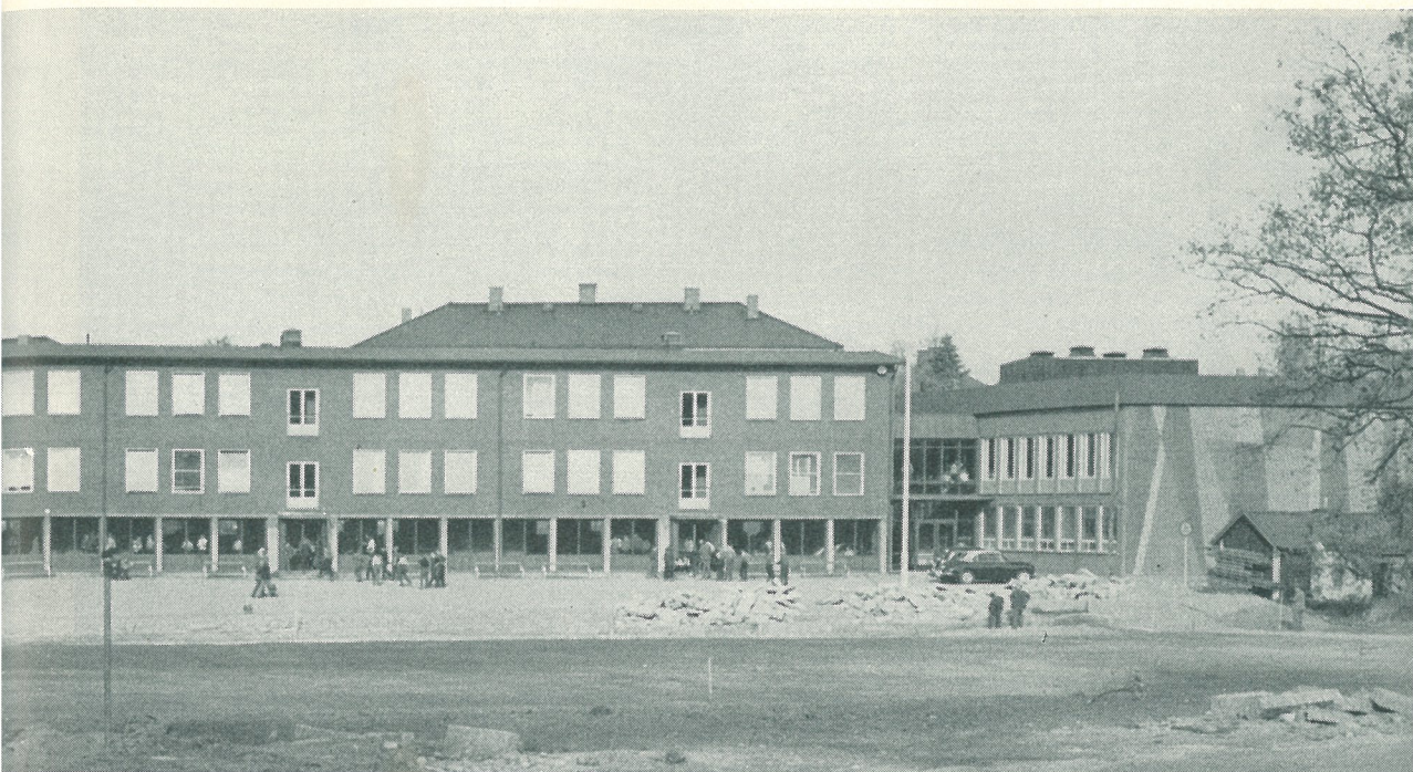
Söderfasaden med institutionsbyggnaden längst till vänster, klassrumsbyggnaden i mitten och barnbespisningen längst till höger. Nedan: Bottenplan i skala 1: 250.
