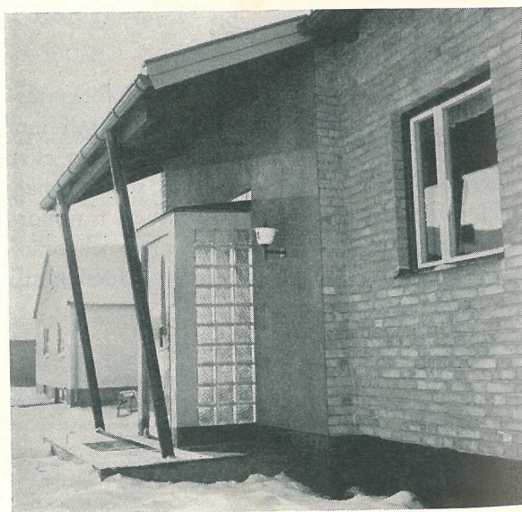
Mottagningsentrén. Baldakintaketets stödör tjänstgör samtidigt som stuprör.
