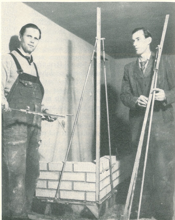
På bilderna på denna sida visar konstruktörerna (Bror Westerlund t. v. och Artur Åkerlund t. h. på bilden t. h.) uppmontering av och murning med hjälp av skiftmallen.
