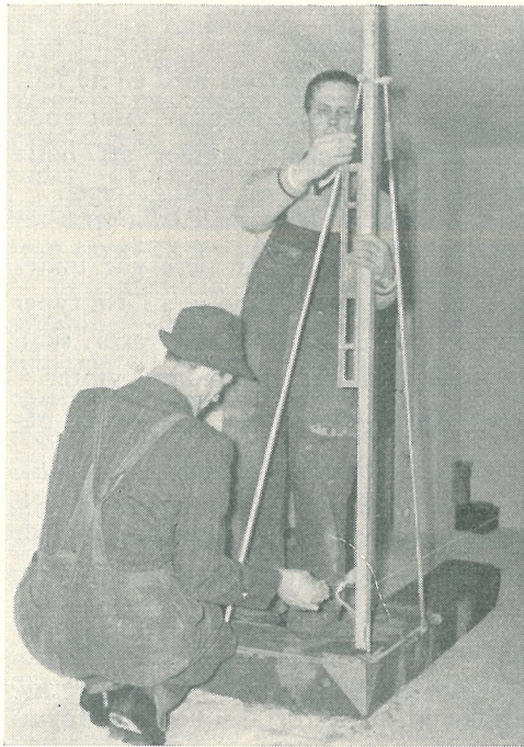
På bilderna på denna sida visar konstruktörerna (Bror Westerlund t. v. och Artur Åkerlund t. h. på bilden t. h.) uppmontering av och murning med hjälp av skiftmallen.
