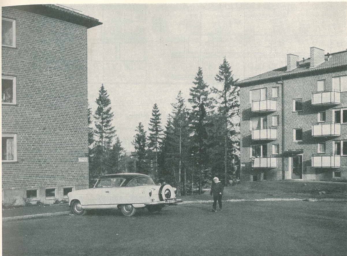
Denna bild från Högdalen visar provhuset t. h. och en annan fastighet murad av 3" tegel, t. v.
