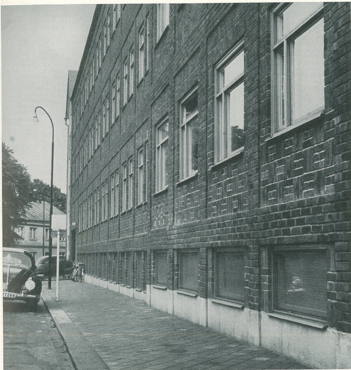
Detaljbild av huvudfasaden.
