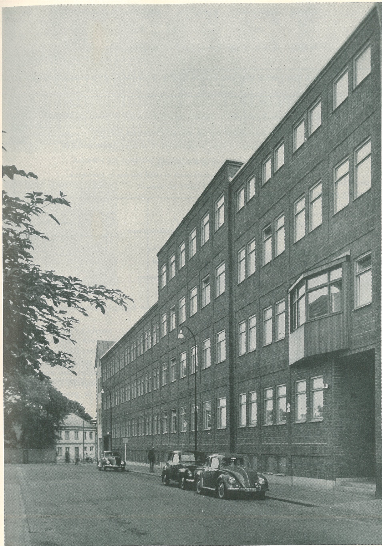
Huvudfasaden. Även med det sparsamma ljus som ligger över denna bild, framträder färgförändringarna som åstadkommits med det färgade fogbruket.
