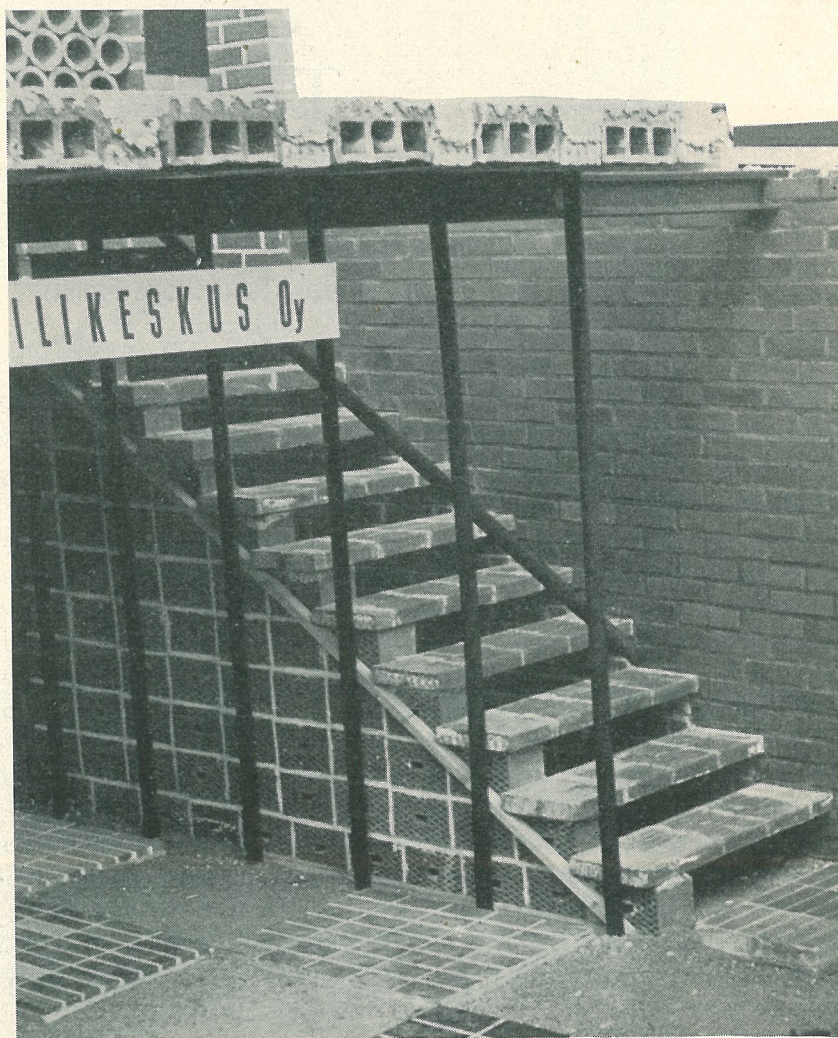
Övre bilden visar en av utställningens mest dominerande konstruktioner — en 20 cm tjock båge av tegelement. Bågen hade en spännvidd av ca 20 m och en pilhöjd av 7 m. Den var utförd av 5 armerade tegelbalkar med mellanliggande utfyllnadsblock. Bilden till höger visar en trappa helt byggd av tegel. Planstegen utgörs av förspända ståltegelbalkar.
