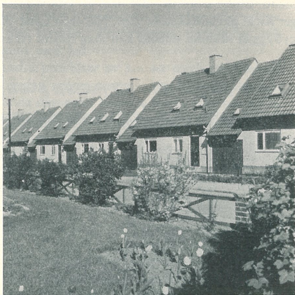
Ovanstående kedjehus vid Palme-Lydersgatan ägs av Bostadsrättsföreningen Brüdigam. De är byggda av byggmästare Gunnar Löfmark efter arkitekt Rune Welins ritningar. Fasaderna är \frac{1}{2} -sten gult räfflat fasadtegel på lättbetong. Lägenhetsytan i varje hus är 110 \text{ m}^2 ; panna och tvättmaskin finns i varje enhet. Anskaffningskostnaden uppgick till 58 000 kr. (Byggnadsår 1953.) Teglet har levererats av Tjustorps Tegelbruks AB, Skabersjö.
