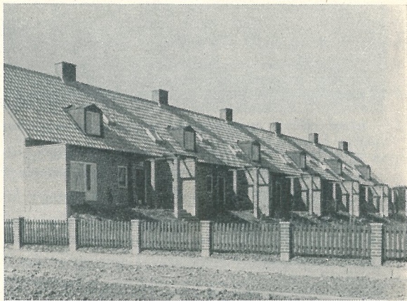
Vid Gustafsgatan har byggnadsfirman Nilsson & Olsson under 1953 uppfört sex radhus efter ritningar av stadsarkitekt Rune Welin. Väggarna är \frac{1}{2} -sten s. k. handslaget rött fasadtegel och lättbetong. Takteglet är gult — tillsammans med takeupornas svartmålade plåtgärningar verkar färgkombinationen som ett djävult experiment. Husen har vardera 102 \text{ m}^2 lägenhetsyta och källare. Varje enhet har egen värmepanna, medan tvättstugan är gemensam. Inkl. tomtkostnad har anskaffningskostnaden preliminärt fastställts till 60 000 kr per hus. (Byggnadsår 1954/55.) Fasadteglet kommer från Yddinge Tegelbruk i Skurup och Cimbrishamns Tegelbruks AB har levererat takteglet.
