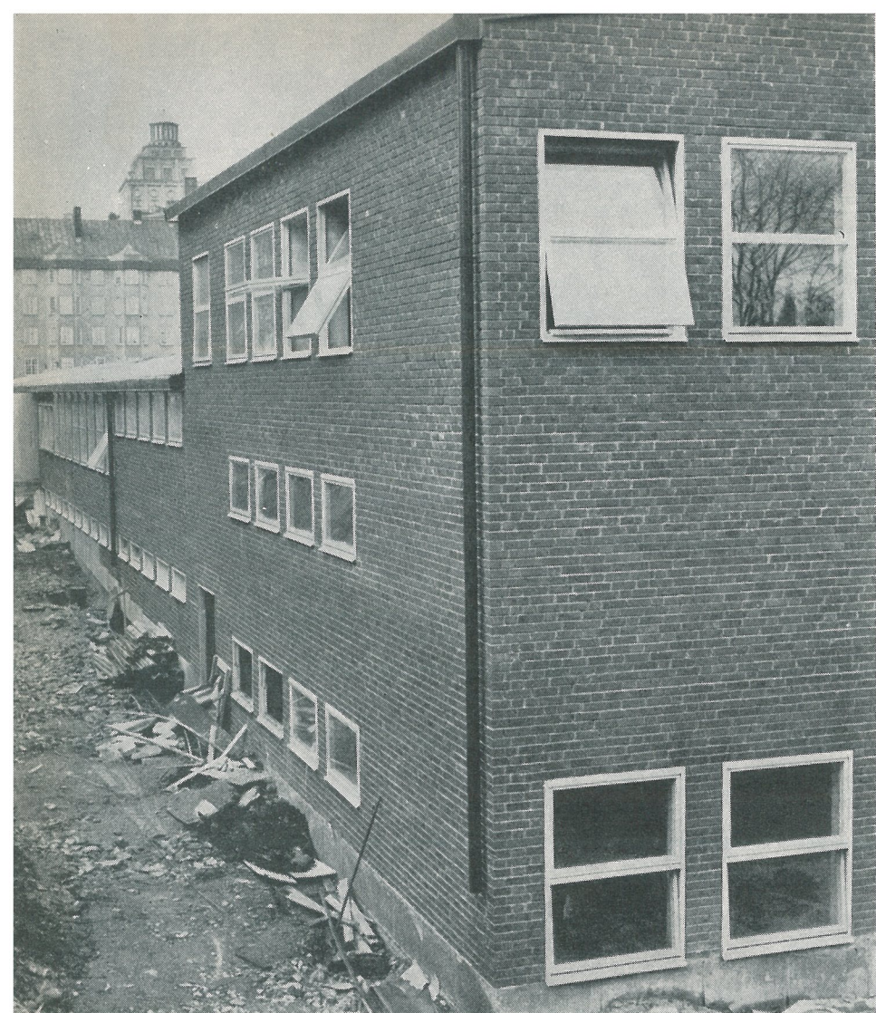
Stor omsorg har nedlagts av murarskolans elever för att få fram ett klanderfritt 10-skifts munkförband i fasaderna. Här Stockholms Stads Lärlings- och Yrkeskolors sydöstra fasadhörn
