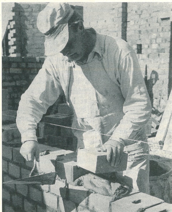
Skiljeväggstegel, format 20 \times 15 \times 8,5 cm
