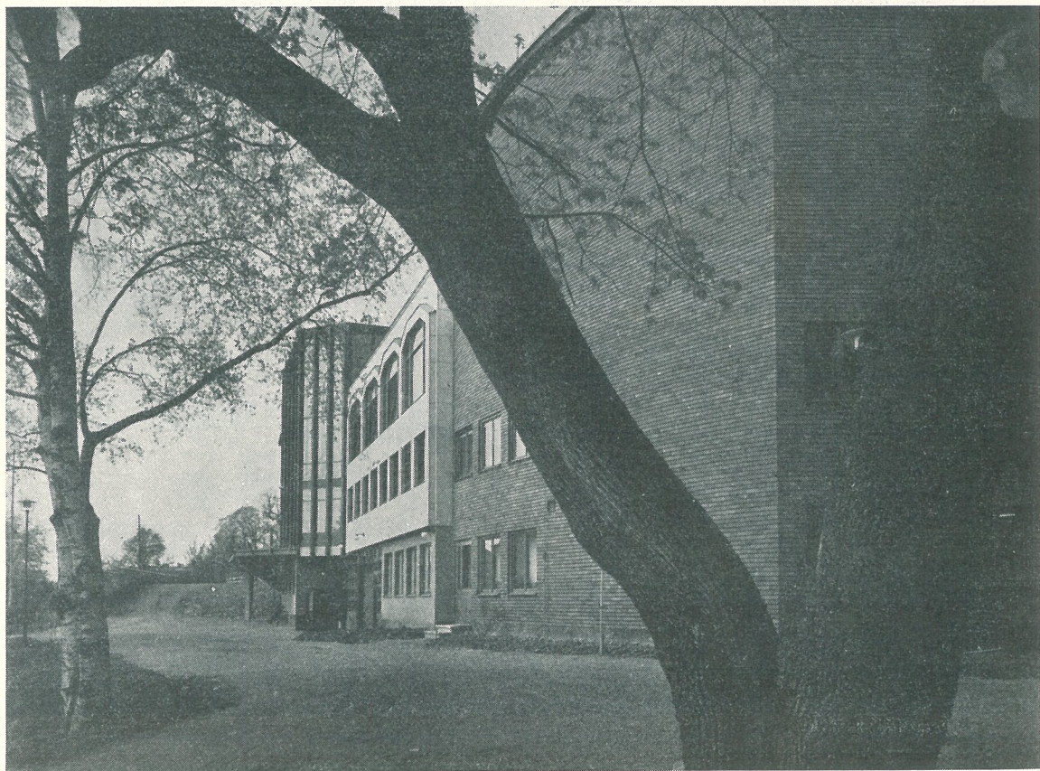
Övre: Fasader mot nämndhuset. Nedre: Fasad mot järnvägen
