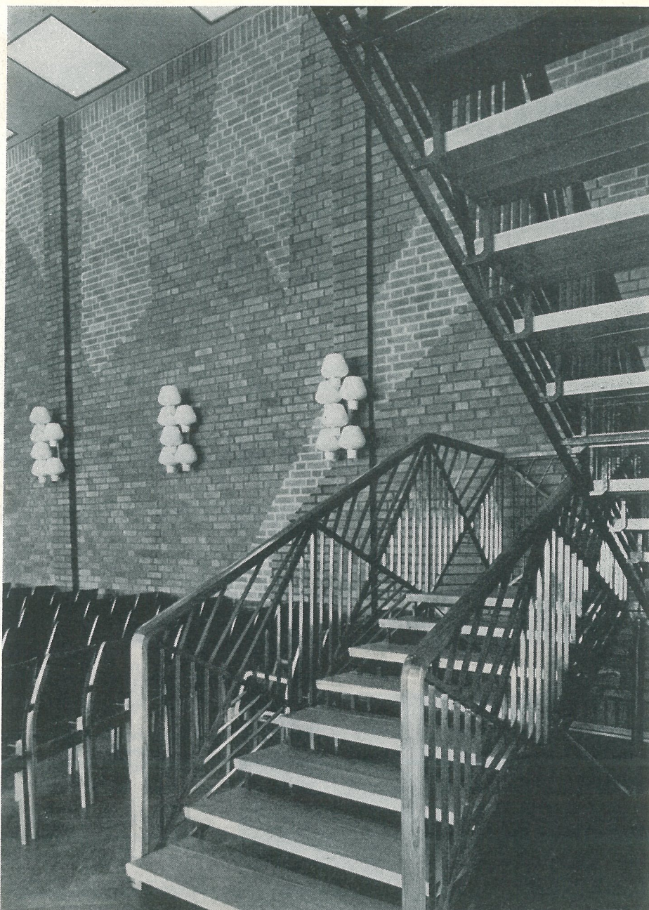
Väggarna i A-salen luta inåt för att accentuera ett stabilt balansförhållande. Det färgade fogmönstret ger liv och rörelse i sin markering av takfönstrens ljusflöden på tegelväggarna
