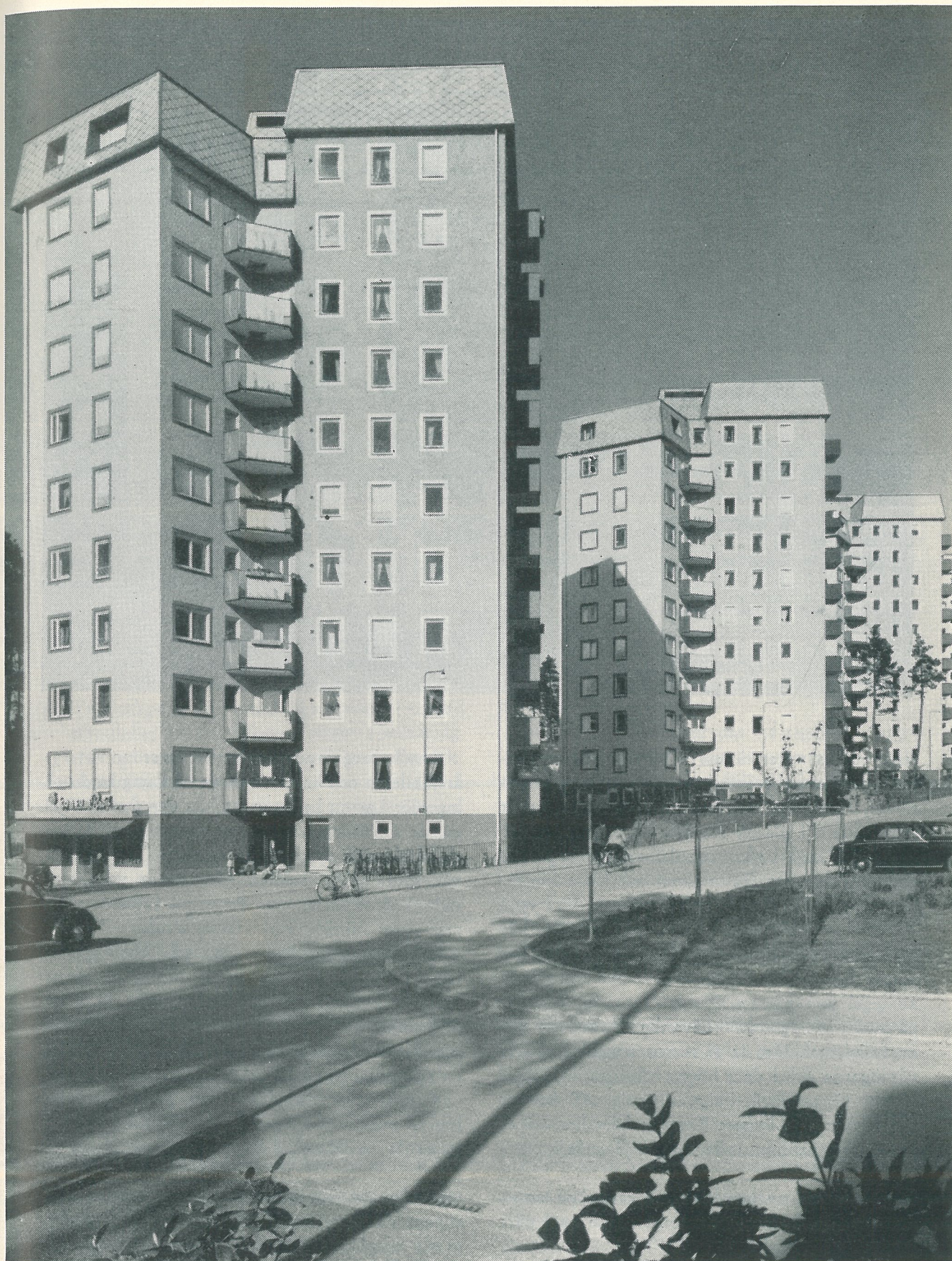
Alla de s. k. Y-husen är putsade tegelhus
