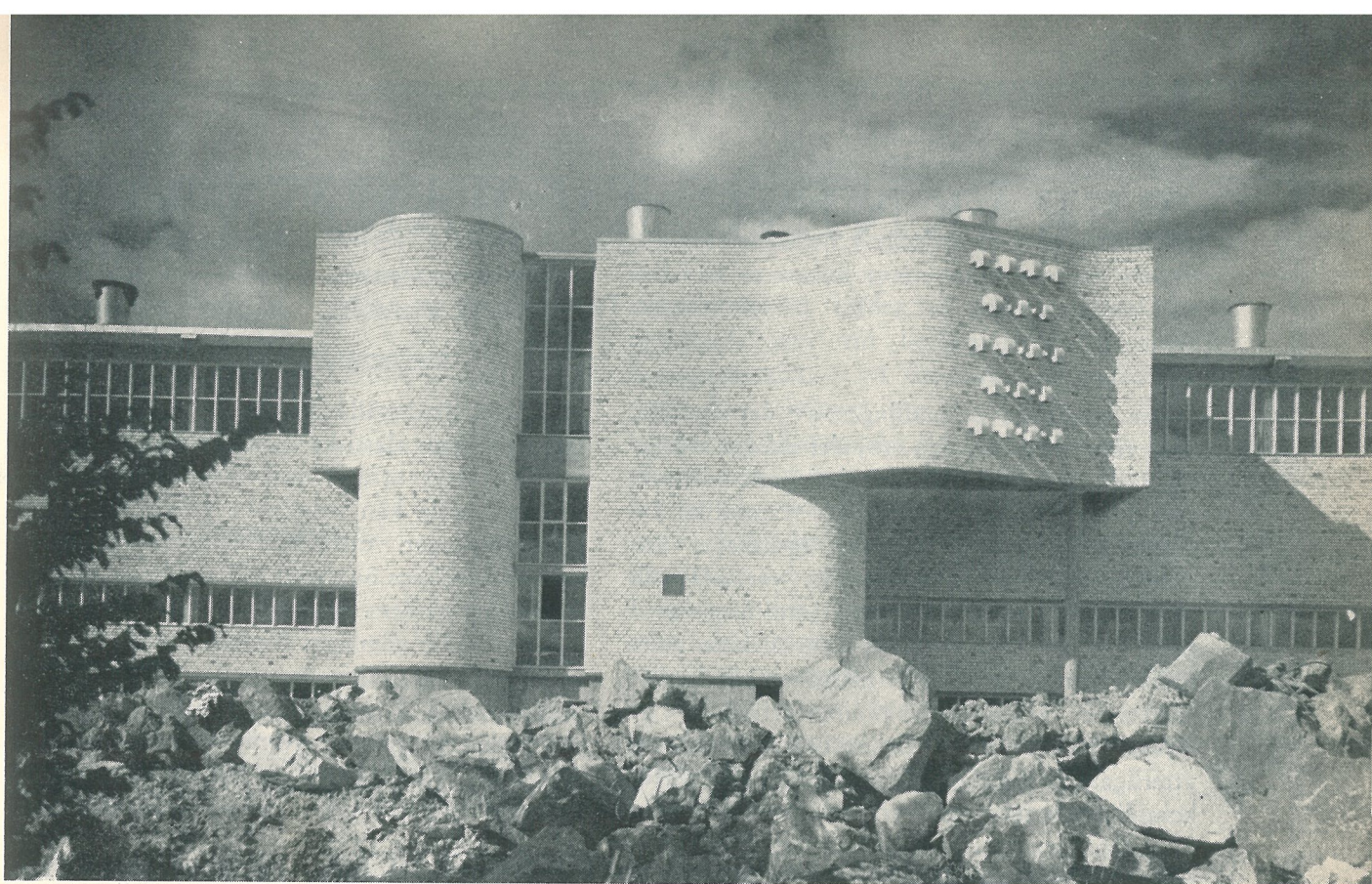
Fläktbus på fabriken östra långfasad. Källarvåning med driftmaskiner under bela byggnaden
