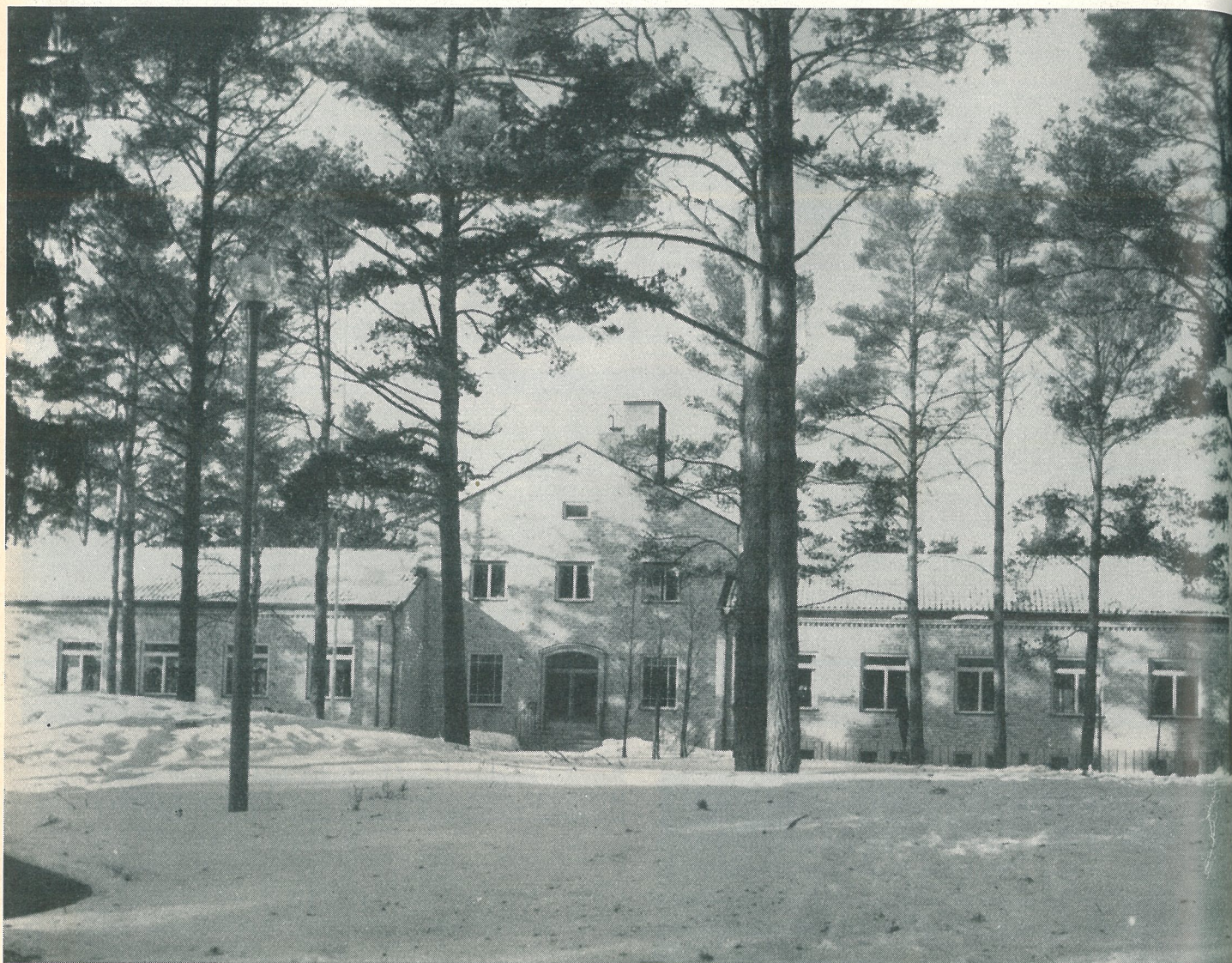
Kök och matsalsbyggnaden
