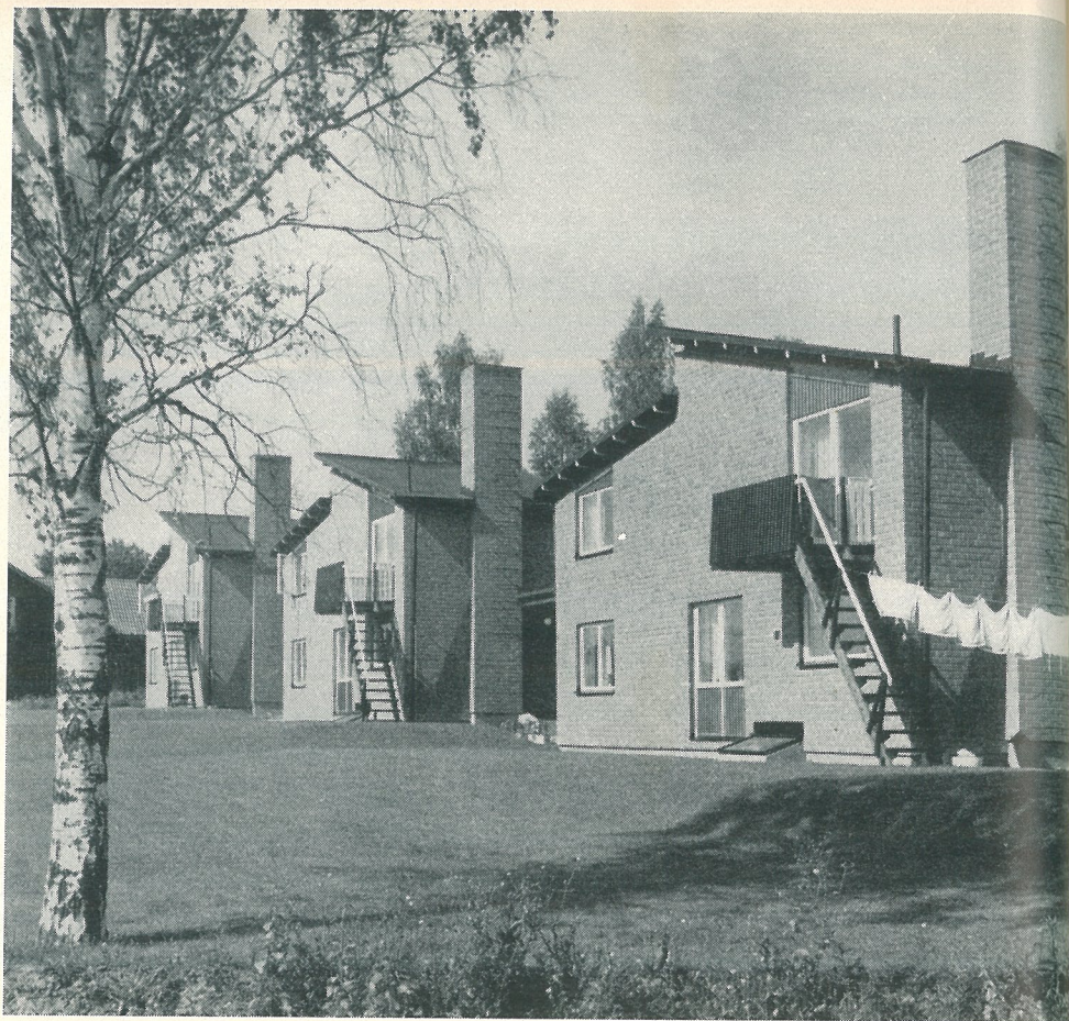
Vissa hus av typ 1 är utförda helt av fasadtegel, gavel- och trädgårdsfasaderna med fyllda fogar, entrésidorna med utkratsade liggfogar
