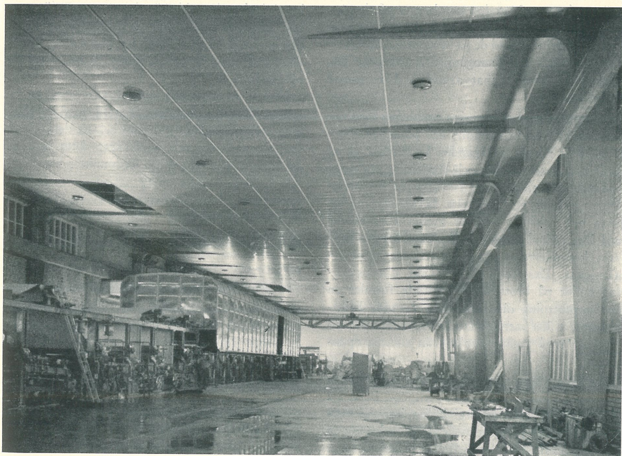
Interiör av maskinsalen visande aluminiumunder-taket, inblåsningsventilerna och kartongmaskinen
