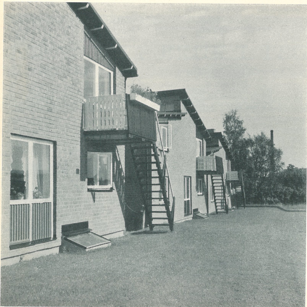
Balkonger från vardagsrum i lätt träkonstruktion. Största delen av dessa samt taksprång impregnerade med Black Varnish (stenkoltjäreprodukt). Resten vitmålade. Källarfönstren utformade så att sockeln kunnat hållas låg. Virke, rotfrukter m. m. kan lätt intagas genom dessa fönster.
