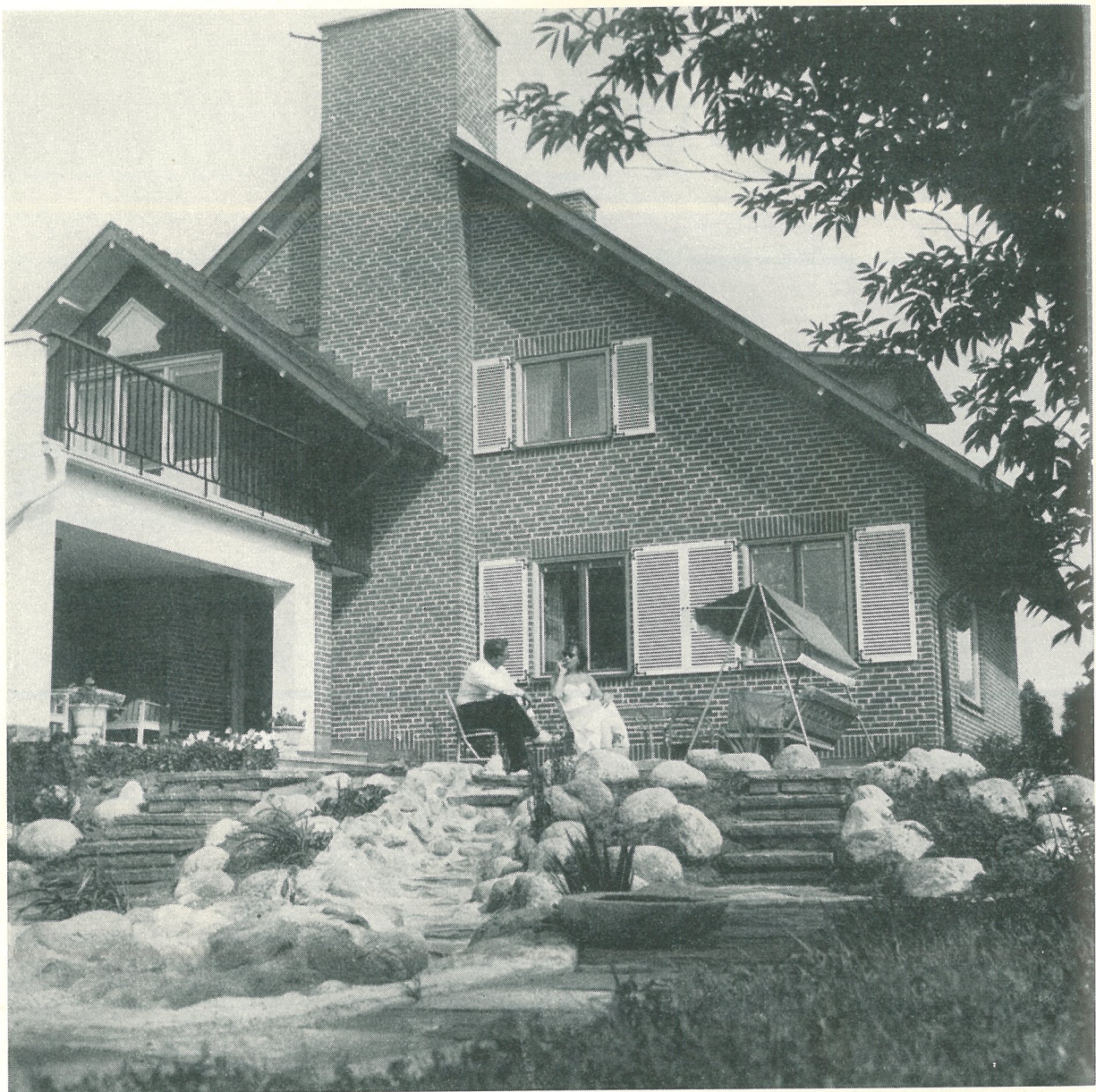
Mjukt som på en vävnad framträder fasadernas "opus spicatum"-mönster Murning i 4-skifts munkförband
