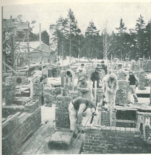
Fig. 1. Stomuppmurning i Stockholm. I alla tre städer "väggades" huset upp, dvs. man murade en halva i taget och satte samtidigt form för betongbjälklag och göt i den andra delen. I Stockholm var hela den del, där murning pågick inplankad. Alla väggar uppfördes där samtidigt. I Göteborg uppfördes väggarna i ungefär samma följd som i Stockholm.
