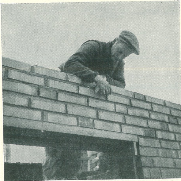
Fig. 10. Fogning av fasad i Stockholm. I Stockholm fogades fasaden med tegelskärv över hand, dvs. samtidigt med att stommen murades upp. Därmed avsåg man att spara uppsättning av utvändigt fogställning.
