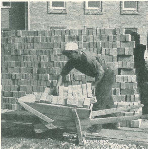
Fig. 4. Materialtransport i Göteborg. I Göteborg kördes teglet ut i skottkärror på betongbjälklaget och flyttades för hand över till murarnas arbetsplatser. Teglet till bakmurning och innerväggar i första stöten stälptes dock direkt ut på betongplattan. Murbruket kördes ut i kärror.
