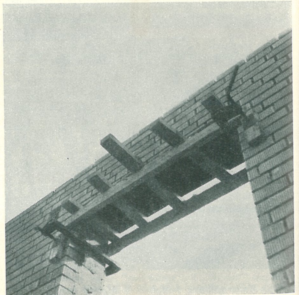
Fig. 13. Fönstervalvbåge i Malmö. En 1" formlucka på fem tvärgående och två längsgående regler hölls uppe av två tvingar, som var fastklämda på muren.
