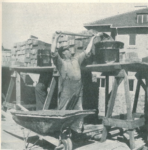
Fig. 8. Murarställning i Malmö. I Malmö bestod murarställningarna av 1 1 / 4 " bräder på bockar. En del bockar var fyrbenta och stagade därför upp ställningen i sidled samtidigt som de bar upp lasten. Mellan dem fanns tvåbenta bockar som blott bar upp last.
