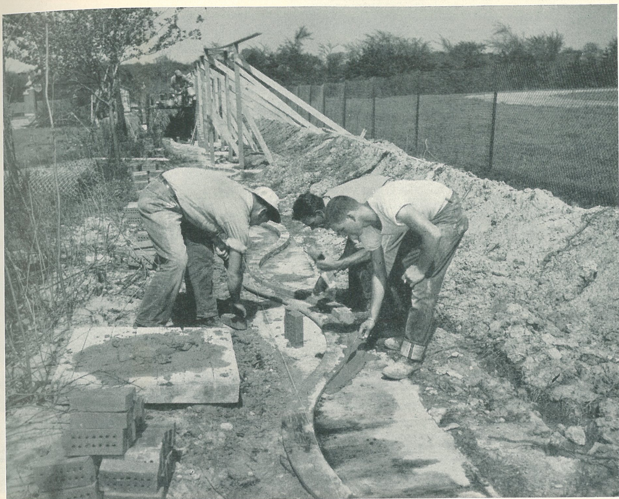
Murens bottenskiift anläggs och inriktas med mall och sträcksnöre
