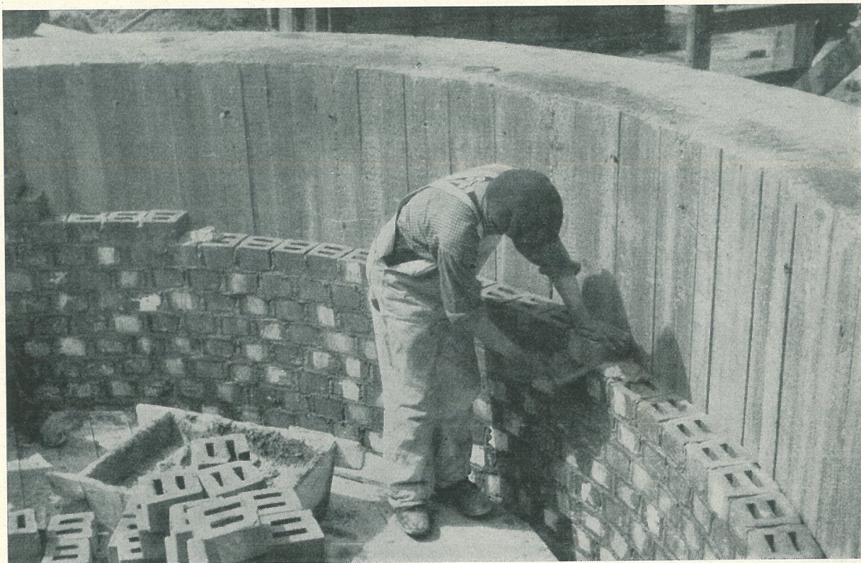
Betongsöckeln skyddas med ett foder
