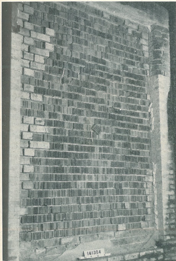
Murväggens eldsida efter 8-timmars brandprovning och efterföljande vattenbesprutning
