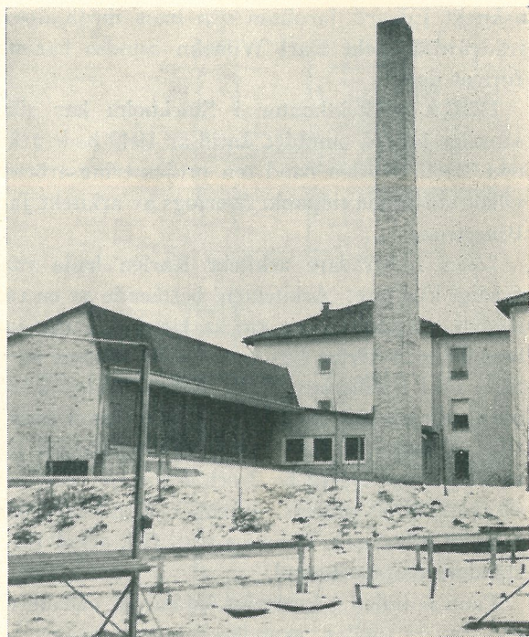
Panncentralen är byggd i gult fasadtegel
