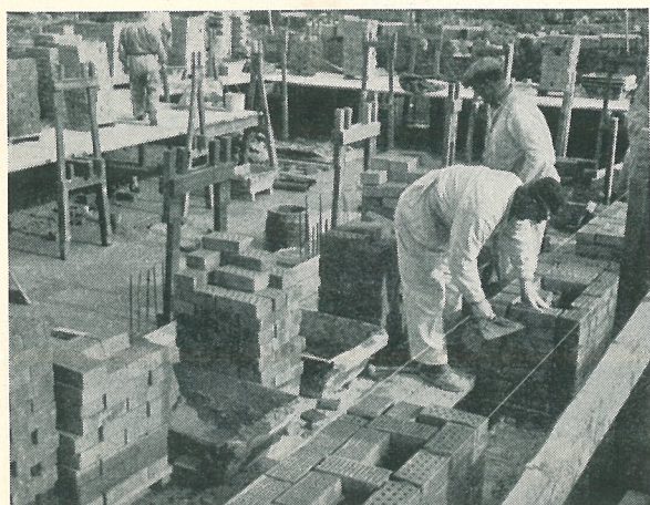
Hålmur under uppförande
