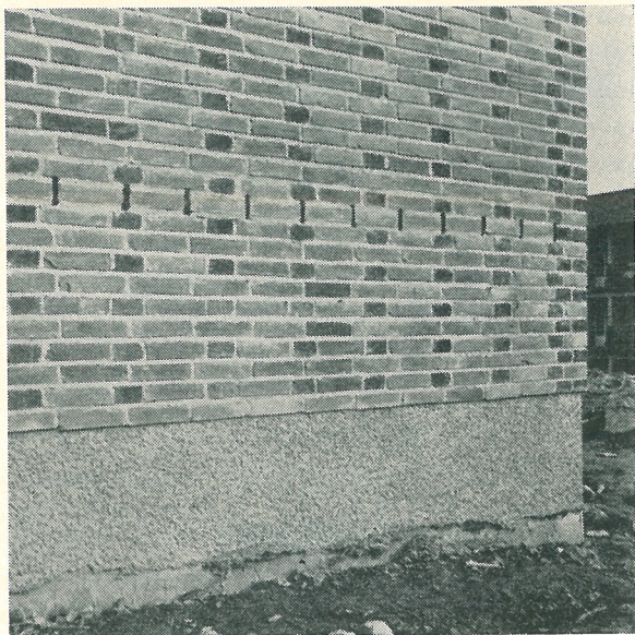
Kanalmurvägg med ventilationshål vid sockeln
