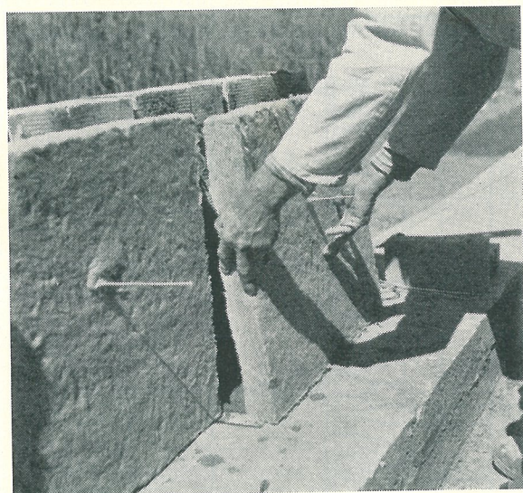
Isoleringsmaterialet trädes över bindaren
