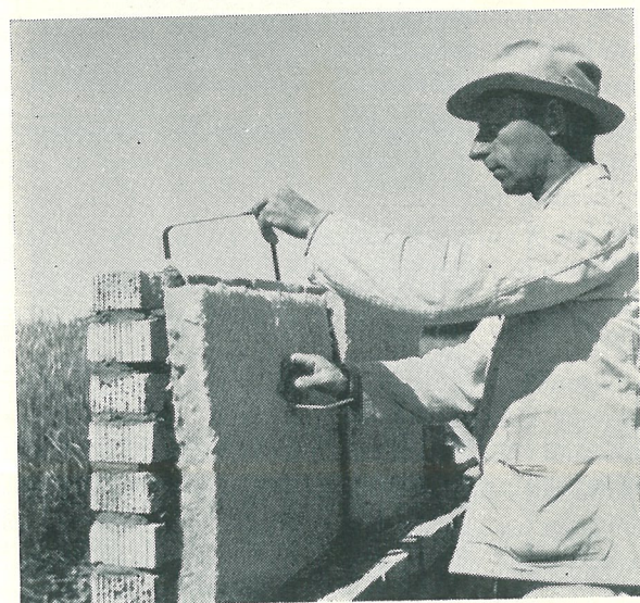
Böjda bandjörn håller skivan på plats under murning
