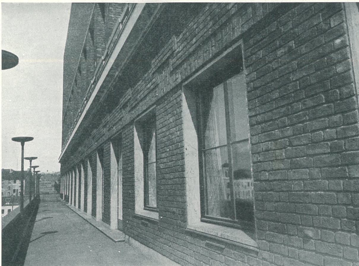
Murverksdetaljer på fasad mot sjösidan
