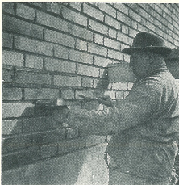
Fogstrykning efter murning från utvärdig ställning
