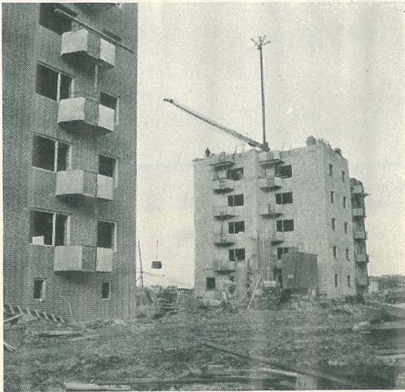
Mastkran med tegelkorg underlättar transporterna
