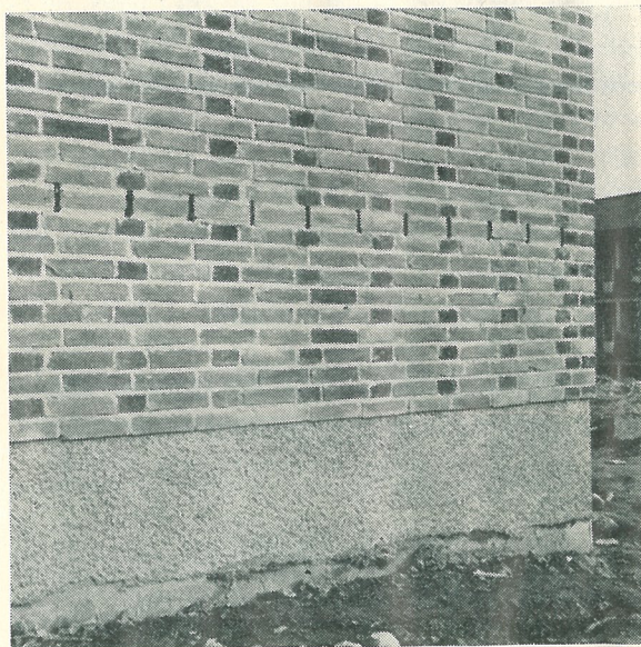
Kanalmurväggen med ventilationshål vid sockeln
