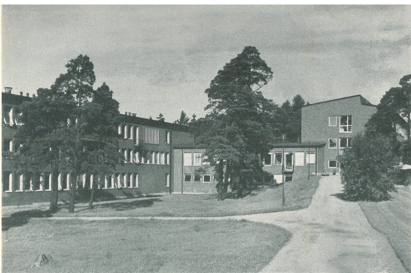
Statens Institut för Folkhälsan, uppfört 1938—1940 i rött sandat 7,5 × 25-tegel från Röbo.
