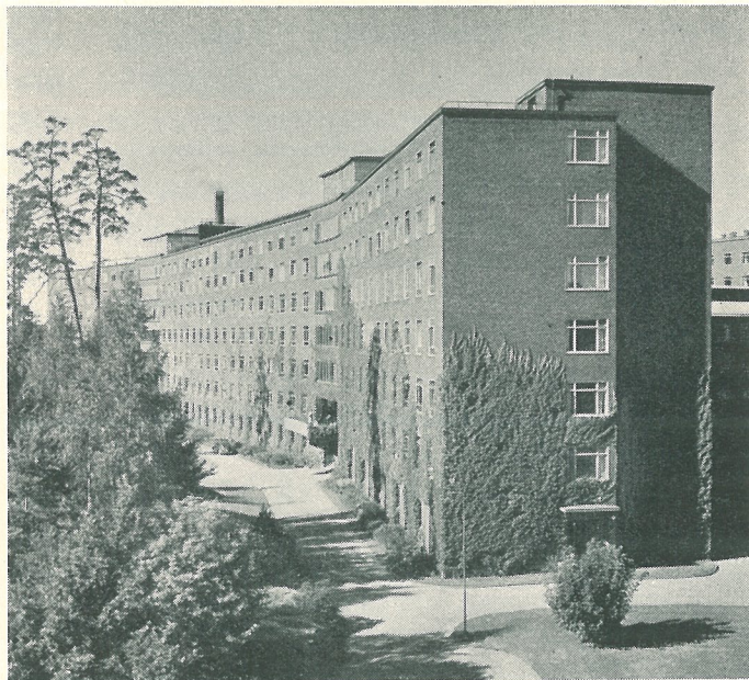
På omslaget: Karolinska Sjukhuset, huvudbyggnadens sydfasad
