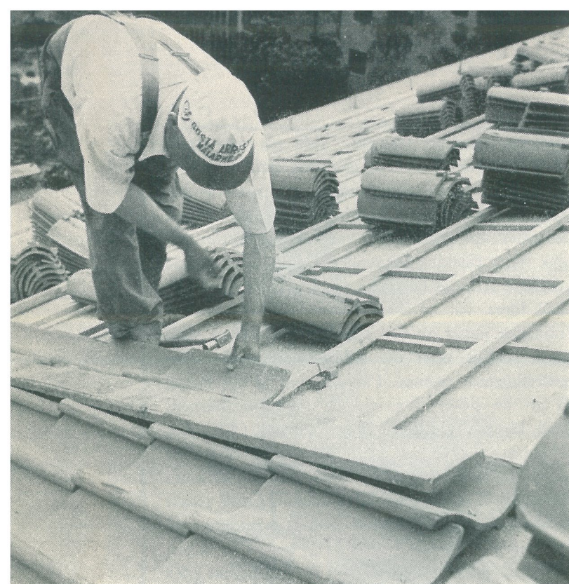
Fig. 15. Med rätskiva kontrolleras raderna efter hand
