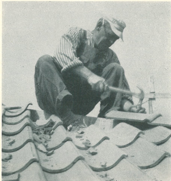
Fig. 21. Nockryggen täckes med nockpannor, som samtliga spikas med galvaniserad spik
