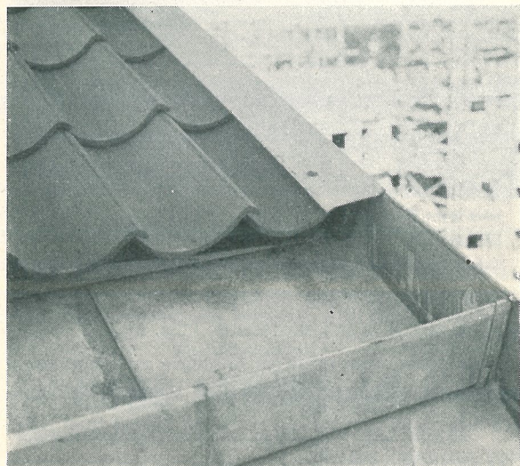
Fig. 23. Gavelanslutning av plåt
