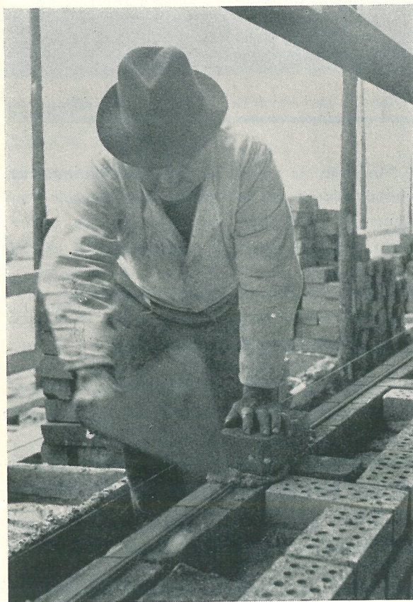
Armering av fasadväggarna
