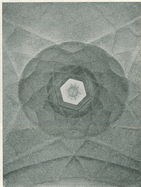
Nedan: Stadshusets portvalv utformat till ett tunnvalv med \frac{1}{2} -stens valvökupa murad på stick. Stickkupor å ömse sidor. "De hundrares valv" i stora tornet. De hundra olika små valvökuporna mellan strålar likna tillhöpa en ädelsten — en jättediamant — med sina olika facetter
