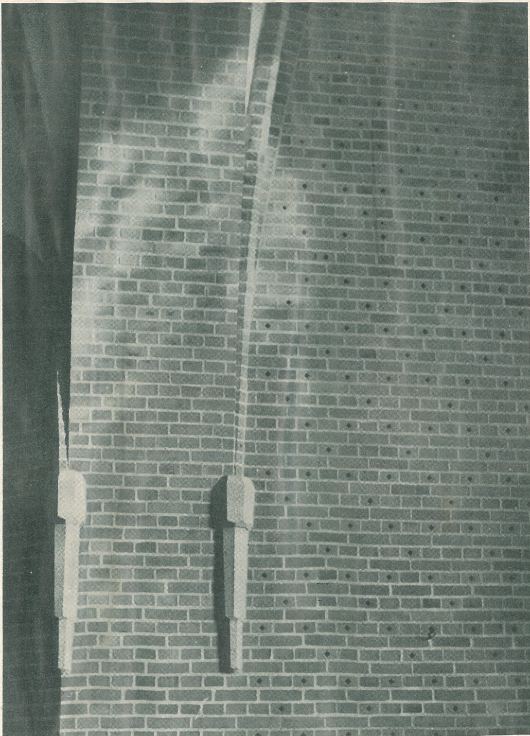
Krysbågarnas anfang markeras av granitkonsoler. Vederlagsmur med ornering av akustiska stjärnhål
