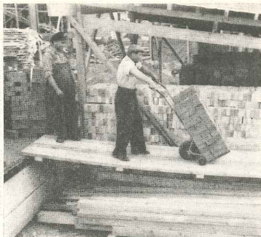
Fig. 10. Gaffelkärrens båda sm extrahjul ge god balans vid kärning å svajande landgångar.
