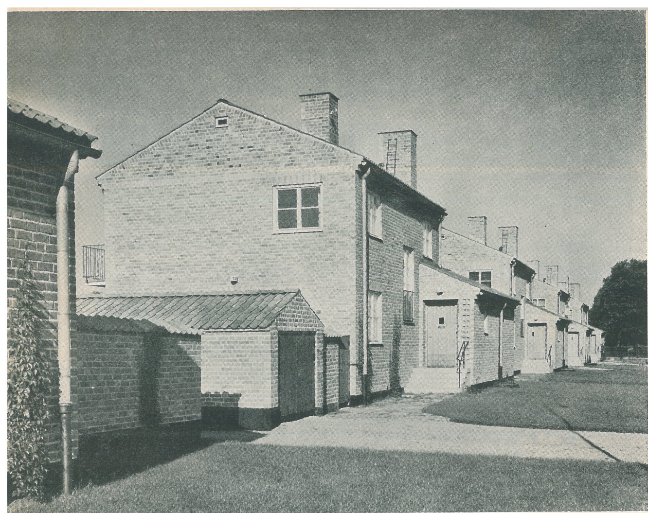
Vy av radhusen sedda från nordost.
