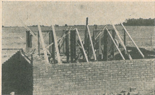
Dörrkarmarna, vilka liksom fönstren äro av järn på grund av termitfaran, sättas upp innan murningen påbörjas, och murningen sker direkt mot karmen.
