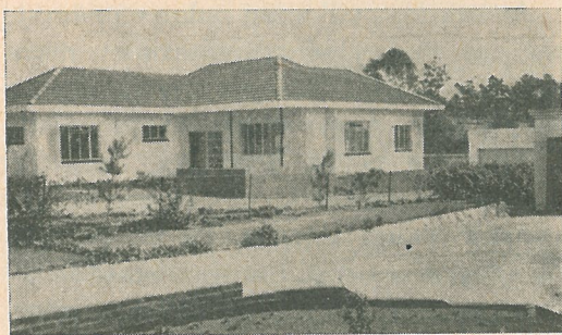
Från Parktown utanför Johannesburg. Taket på de sydafrikanska villorna få ofta en orolig form på grund av byggnadernas invecklade planlösning. Oskyddade tegelmurar kring trädgårdarna kunna användas, när risken för frostsador är ringa.
