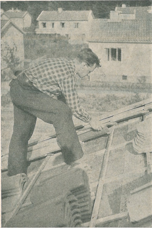
Fig. 1 Takteglet utlägges på tegelläkt, vilken spikas på ströläkt. Härigenom kan under takpannorna eventuellt inträngande vatten lätt rinna av. Observera "övertäckningen" mellan de olika pannorna ävensom vindskivans täcklist ytterst, under vilken takpannorna gå in.
