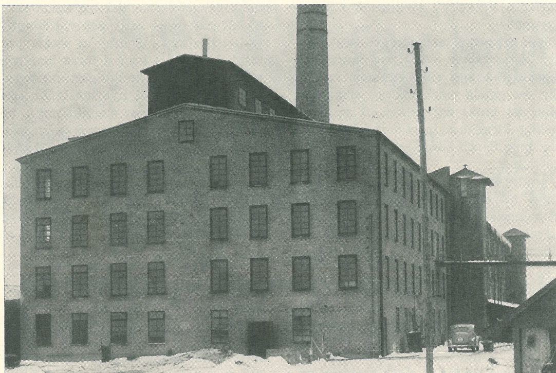
Bild 1. Exteriör av maskinhuset.
