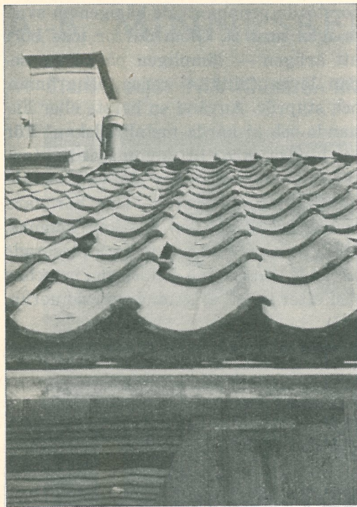
Fig. 5. Även det bästa kan misslyckas. Takteglet flagar av, troligen beroende på att råteglet utsatts för kyla före bränningen.
