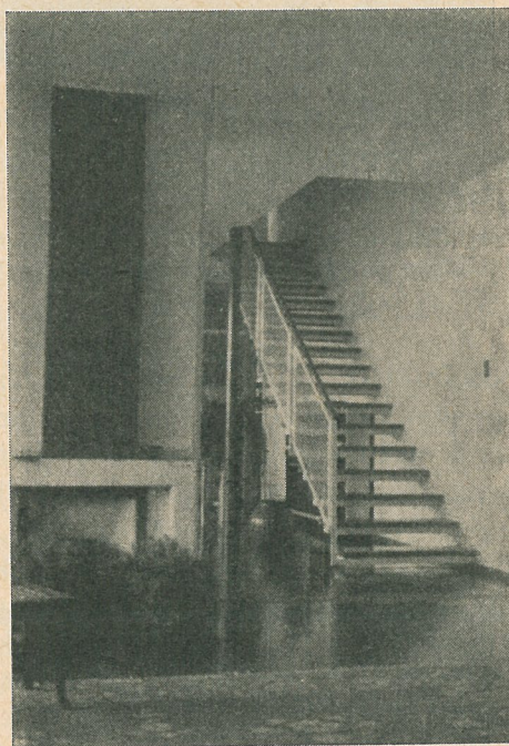
Interiör från villan på föregående bild. Ovanför den öppna spisen bildar teglet i skorstensstocken en effektfull kontrast till de vita väggarna. Den fribärande trappan med stegen förankrade direkt i yttermuren är även av intresse.
