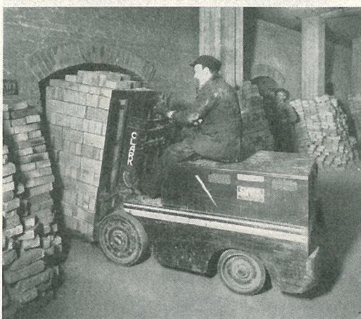
Fig. 16. Trucken backar ur ugnsporten med lass. Sveriges första tegeltruck i arbete.
