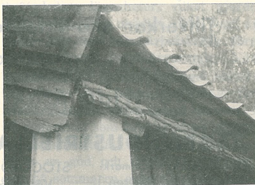
Fig. 6. Ett gammalt torvtak, som täckts med tegel. Observera nävern, som tjänstgör i stället för papp, och vattenhålen i fotbrådan.
