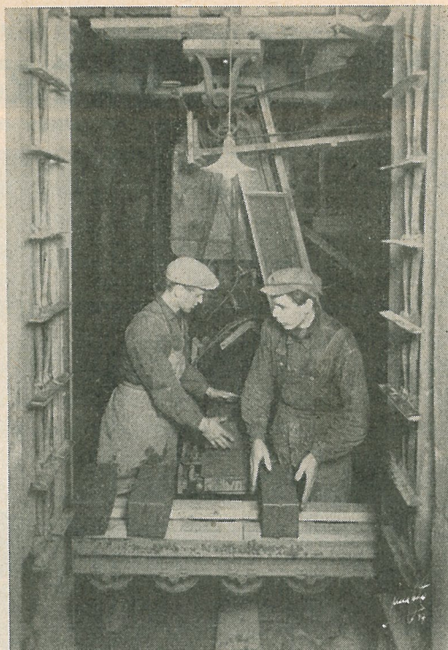
Fig. 2. Två man plockar ca 40 000 sten om dagen från skärbordet fram på automatiskt framförda lattor, eller på gamla höjelevatoren.
