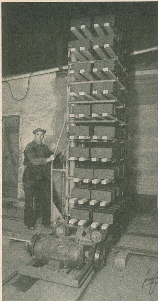
Fig. 5. Gaffelvagnen med dubbellast föres på el. traversen och köres till torkan.
