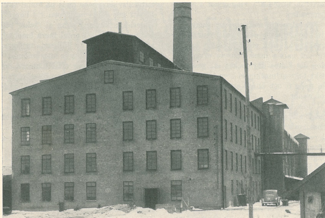
Bild 1. Exteriör av maskinhuset.
