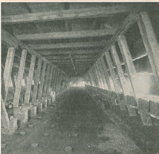
Stora ringugnen med överliggande storrumbstorka.
