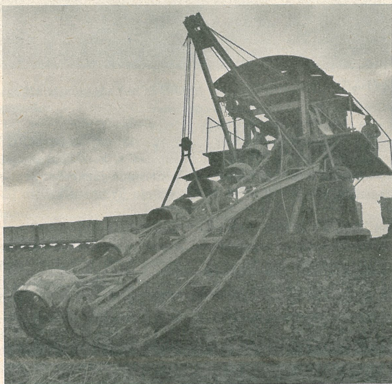
Bild. 2. Leran upptages med grävmaskin och lastas på vagnar.
