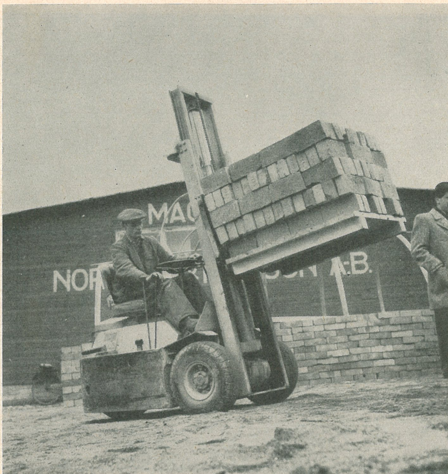
Bild 2. Trucken har fångat tegelpaketet och lyfter detsamma. Observera att de vid demonstrationen använda trälämmarna icke äro erforderliga om man använder en lämplig utformad gaffel. (Foto: Järlås.)
