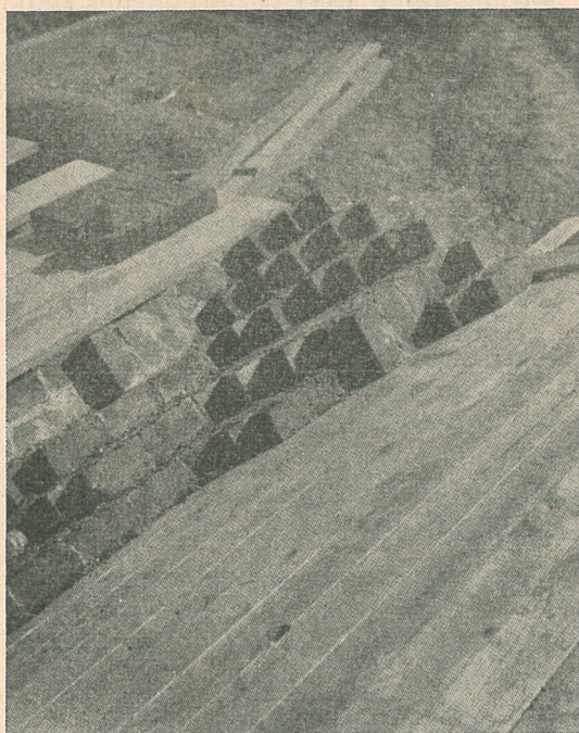
Fig. 2. Detaljbild av murningsförbandet.
