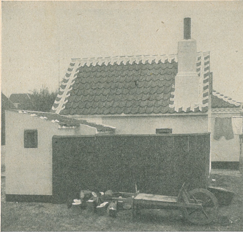
Fig. 24. Fotografi som visar utvändigt vitmenad fogning å tegeltakets nock och gavlar samt att skorstenen är vitmenad tillsammans med fogningen oavsett om huset är kalkat gult eller rött.
