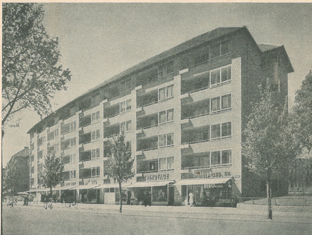
Fig. 28. Knud Hansen: Bostadshus i Bispeparken vid Tuborgvej för Socialt bostadsbyggande. Ofogade fasader murade med utvalda murtegel med baksidan utåt i KH-förband och med på platsen gjutna balkongburspråksbröstningar i betong. De små betongblomlådorna insattes färdiggjutna i balkongräckverkets gjutform.
