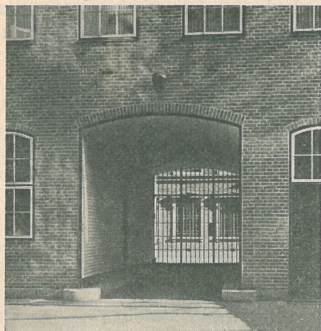
Fig. 9. Povel Baumann: Port för egendomen Nørrevold 32—34, sedd från gården. Hörnjärnen skilja den fogade fasadmuren från den vitmålade porten.
