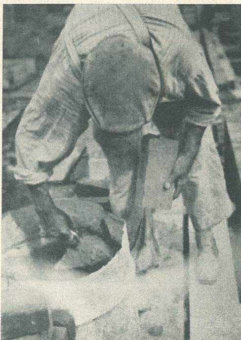
Fig. 5. Murningsarbete på ladugårdsbyggnad i Skåne. (Jordbrukets byggnadsstudiekommitté JBK 1944)
