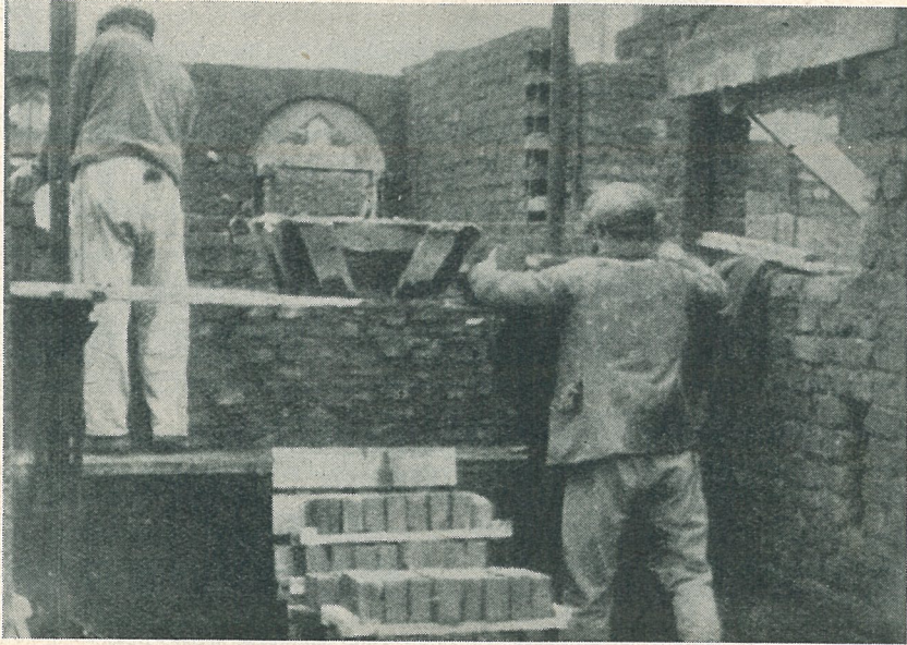
Fig. 14. Transport av paketerat tegel. Hanilangaren lyfter ett tegelpaket från kärnan till ställningen (Werzner 1930).
