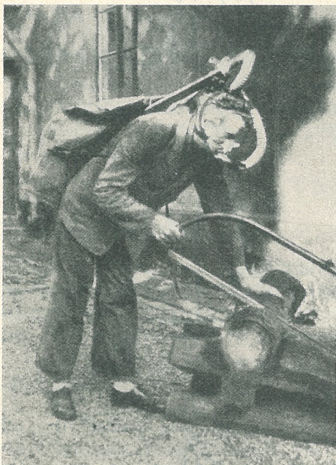
Fig. 3. Energimätning vid sågning enligt Douglas' säckmetod. (VSA 1942)
