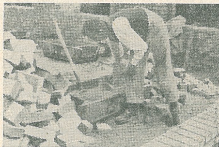
Fig. 4. Påläggning av bruk med slevspetsen.
