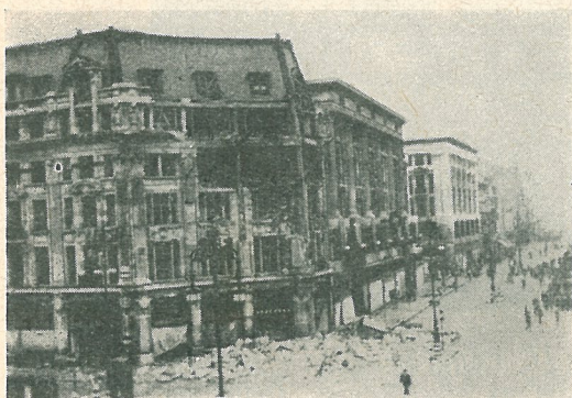
Fig. 9. Byggnad med bärande stomme av järnbalkar träffad av en medeltung minbomb. Genomslaget i mittersta takfönstret. En del av fasaden har störtat in, men bjälklagen äro i huvudsak hela. Beklädnadsstenen på fasaden har i stor utsträckning raserats. (London). (Luftskyddsinspektionens bildkompendium.)
