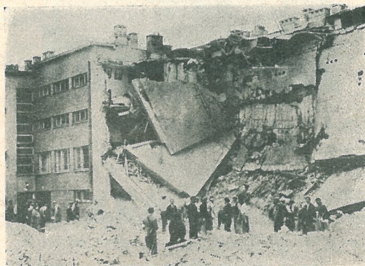
Fig. 4. Tegelbyggnad med betongbjälklag träffad av 100 kg:s minbomb. Ena ytterväggen har tryckts ut och bjälklagen störtat in. (Spanien). (Luftskyddsinspektionens bildkompendium.)
