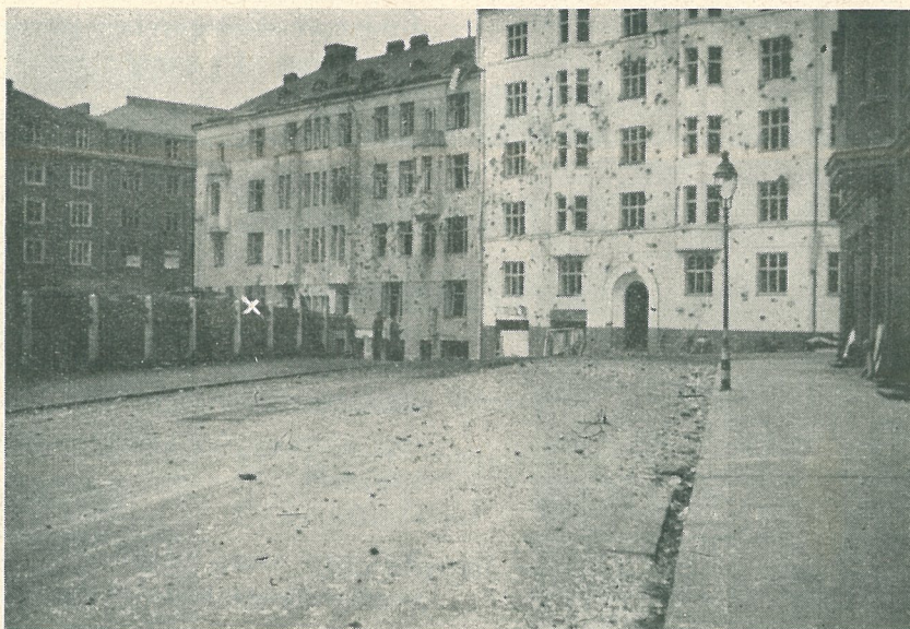
Fig. 11. Samma hus som i fig. 10. Bomben träffade enligt upplysningar vid x. (Fotot erhållet från Finland.)
