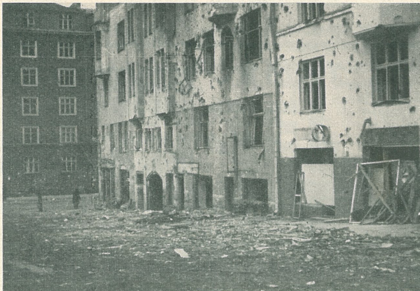
Fig. 12. Samma hus som i fig. 10 och 11. Enligt uppgift var splitterverkan på granitgrunden lika stor som på tegelväggen. Detta har troligen sin förklaring i den låga elasticitetsmodulen, som tegel har. (Fotot erhållet från Finland.)
