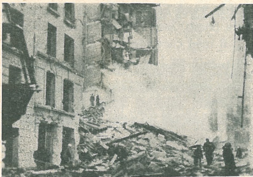
Fig. 3. Tegelbyggnad med träbjälklag träffad av tyngre minbomb (troligen 300 kg). Observera att en del av byggnaden står kvar och att denna skurits av vertikalt. Dålig sidostabilitet. (Paris). Luftskyddsinspektionens bildkompendium.)
