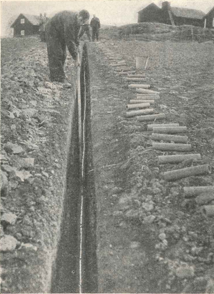
Fig. 7. Justering av dikesbotten. Den ljusa randen på bilden är vatten. Justeringen fortsättes tills vattenranden blir jämbred i hela diket, vilket är ett kriterium på att botten har jämnt fall. — Ur Lantbrukshögskolans hydrotekniska institutions bildsamlingar.
