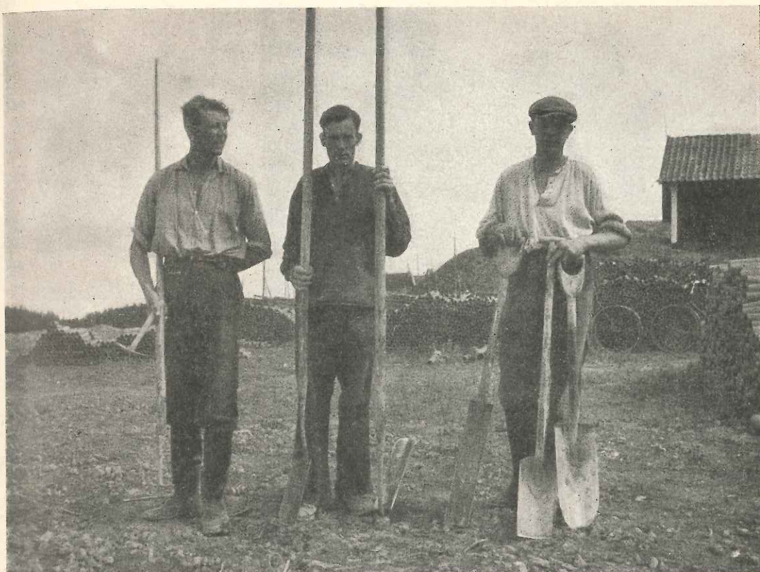
Fig. 6. Olika dräneringsverktyg. Längst till höger två olika typer av spadar samt skyffel. I mitten dragskopa för gravjustering av dikets botten samt skjutskopa för efterjustering. Till vänster hammare för tegelbearbetning och krok för rörläggning. — Ur Lantbrukshögskolans hydrotekniska institutions bildsamlingar.
