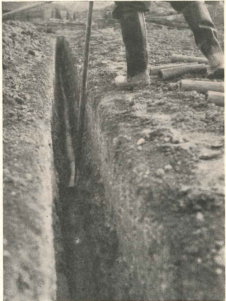
Fig. 9. Rörläggning med tillhjälp av rörkrok. Vid läggningen passas rören noggrant tillsammans ända mot ända så att fogarna bli så täta som möjligt mot jordmaterial. — Ur Lantbrukshögskolans hydrotekniska institutions bildsamlingar.
