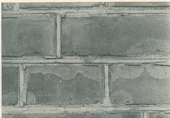
Fig. 1. Facade af lysegule Teglsten faa Maaneder efter Opmuringen.
