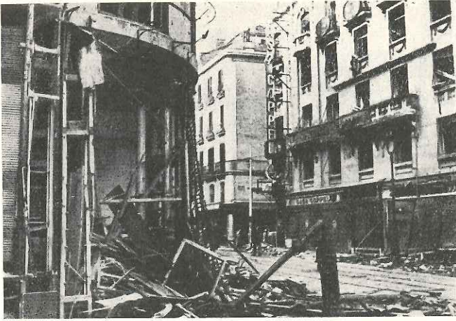
Fig. 5. Genom luftstötens vakuumverkan sugas lätta fönster, ytterdörrar, balkongdelar o. s. v. ut på gatan.
