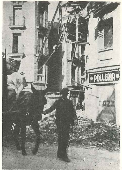
Fig. 4 b. Lätta balkonger, burspråksväggar o. d. kastas genom bombens verkan ut på gatan.
