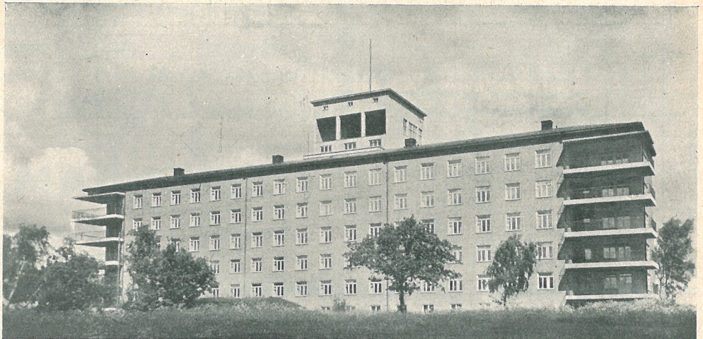
Ovanstående och nedanstående bilder visa Kalmar Centrallasarett. Byggnaderna äro uppförda av fasadtegel av Berga tillverkning med bakmurning av vanligt murtegel utom ångpannecentralen som är av vanligt murtegel jämte högporöst och hisstornet på huvudbyggnaden som är av betong. Arkitekt G. Birch-Lindgren.
