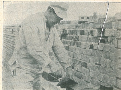
Vidstående murare i arbete får tjäna som symbol för denna sammanställning av bilder av några nyare tegelbyggnader.
