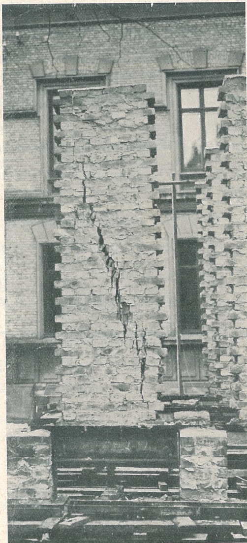
Murpelare med kalkcementbruk av 1,4-tegel.
