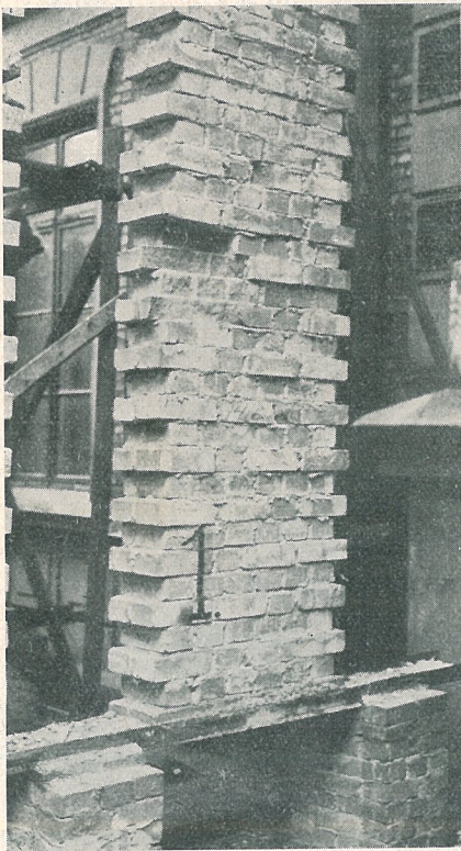
Murpelare med kalkbruk av 1,4-tegel.
