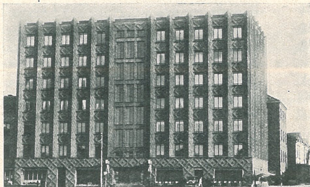
Affärshus i Tallinn, Estland. Byggt av tegel.
