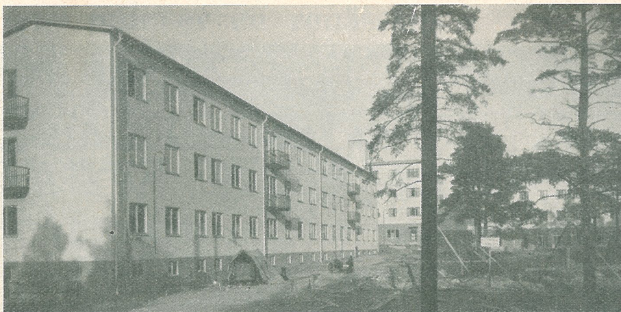
Fig. 13. A. B. Familjebostäders nybyggnad å Hammarby.
