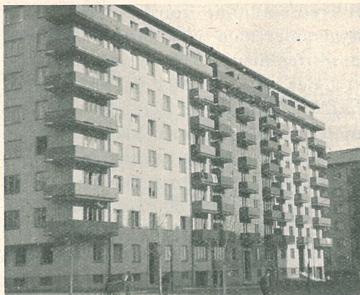
En länga av Gärdeshuset byggd av tegel från grund till tak.
