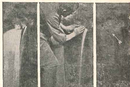
Vattengenombrott tätat på ett par minuter med Tricosal S III (snabbbindande).
